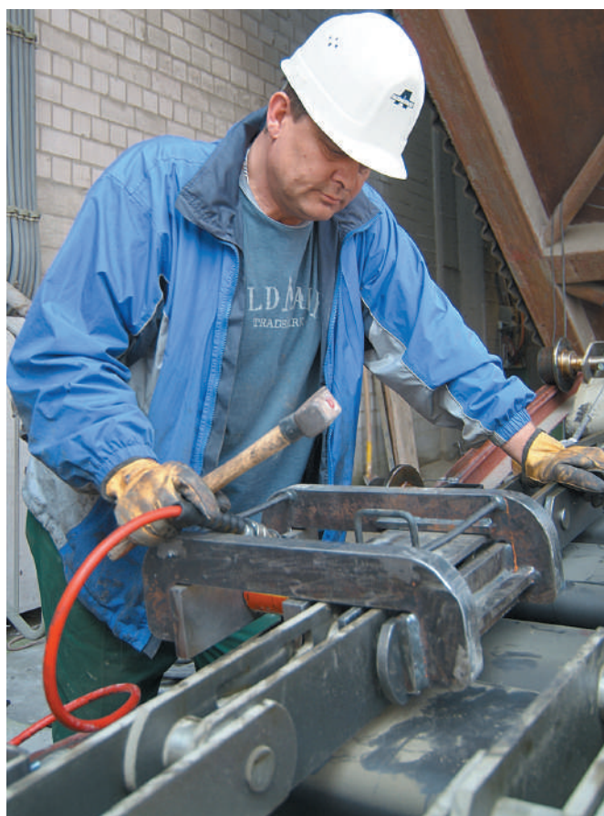
Предварительно смонтированные ветви цепи
