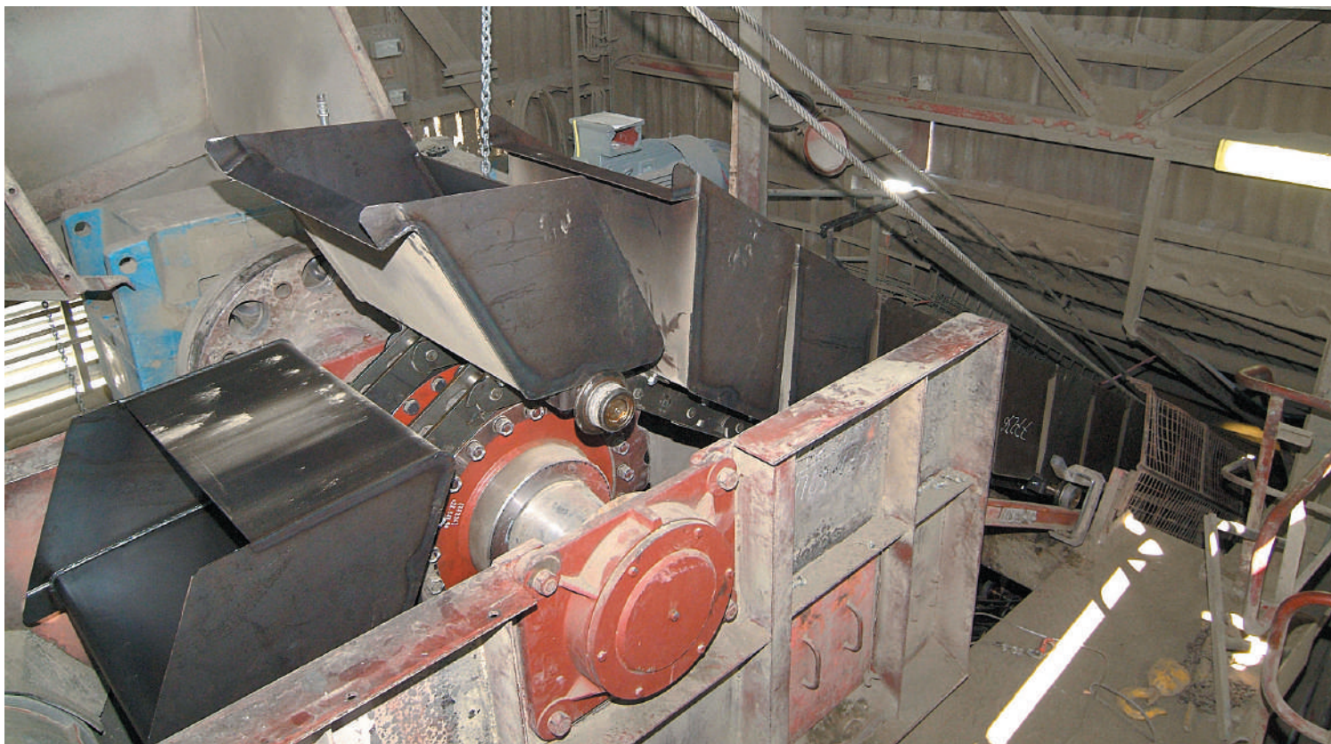
Установка новой ветви ковшового транспортера
