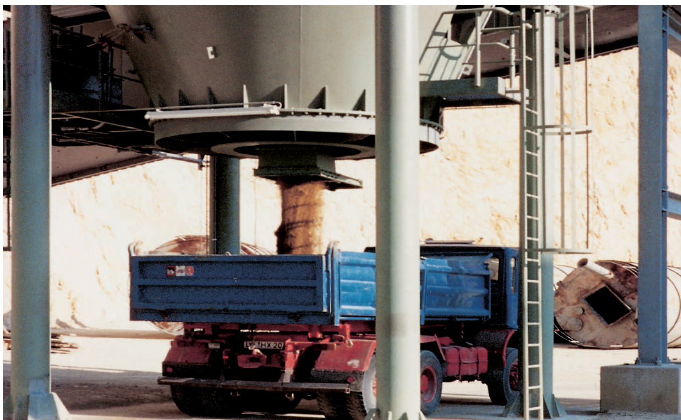
CENTREX® с внутренним приводом. Разгрузка из металлического силоса с последующей погрузкой на автотранспорт
