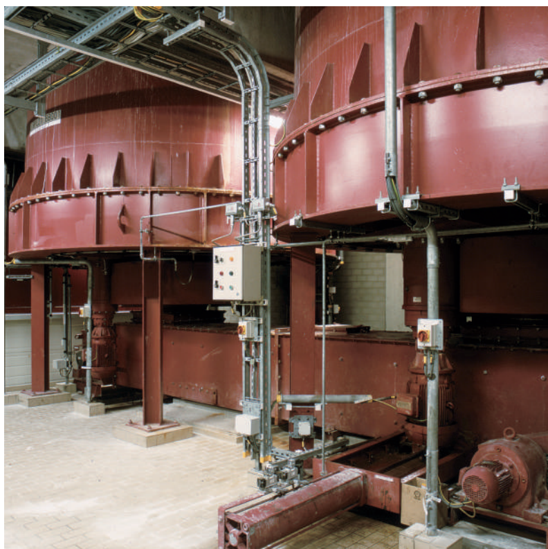
Устройство CENTREX®, тип СТХ-А с внешним приводом для разгрузки гипса (FGD), получаемого при десульфуризации дымовых газов
