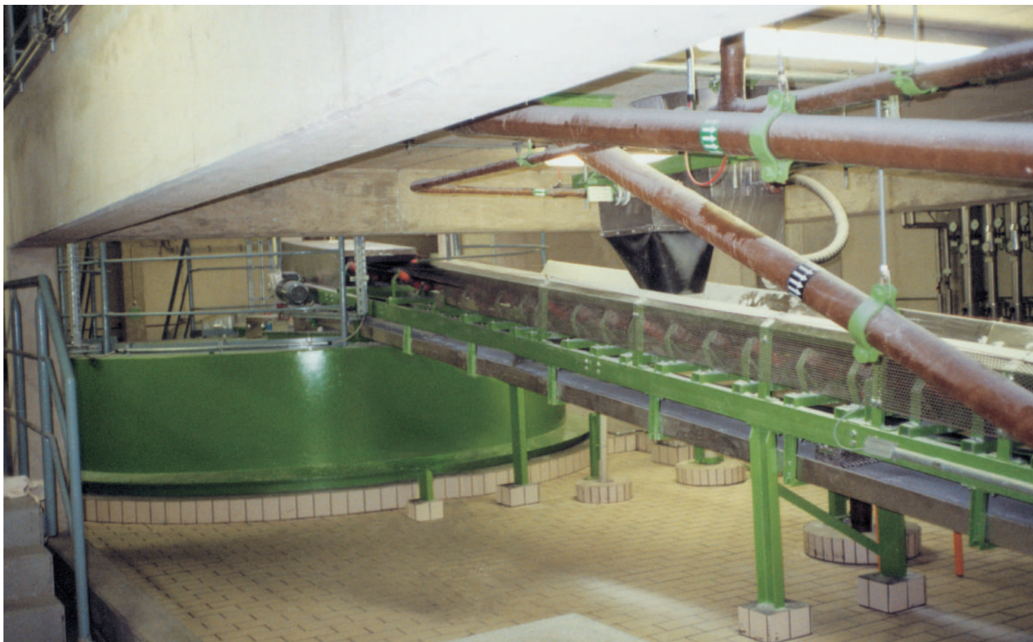
CENTREX® - подача сернокислого кальция в силос
