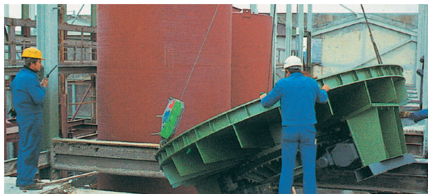
Сборка на месте устройства CENTREX® в нижней части силоса
