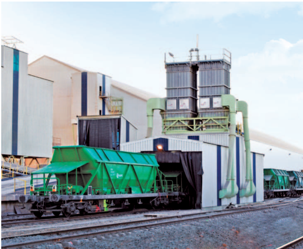
Разгрузочная установка для вагонов с донной разгрузкой, для приема угля на цементный завод, с питателем Samson® производительностью 80 т/ч
