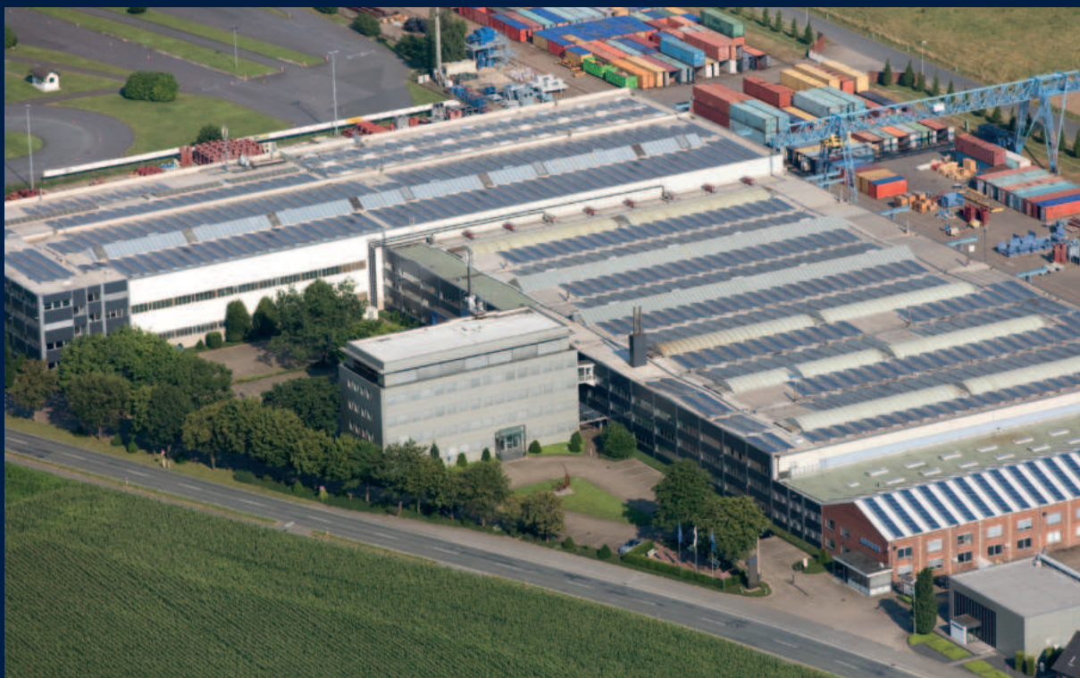
Штабквартира компании AUMUND в г. Райнберг, Германия
