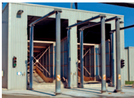
Сигнальная система для контроля работы грузовиков
