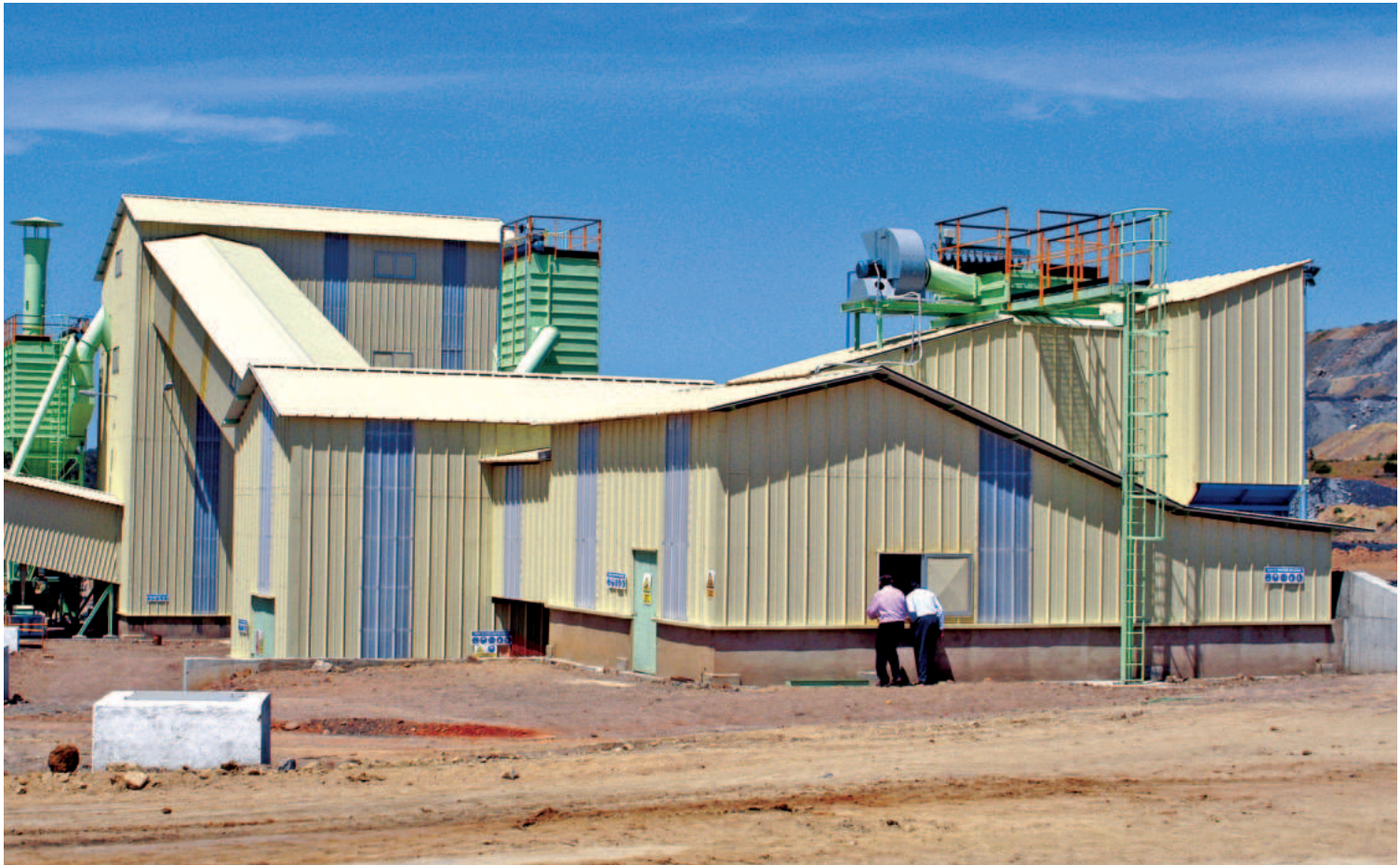
Укрытие питателя Samson®, интегрированное в углеобогатительную фабрику на приеме несортированного материала с близлежащего карьера
