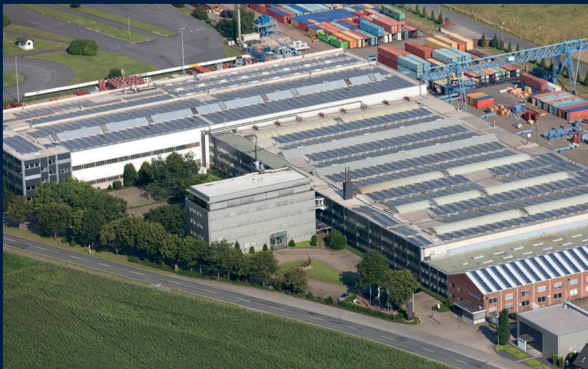
Штабквартира компании AUMUND в г. Райнберг, Германия
