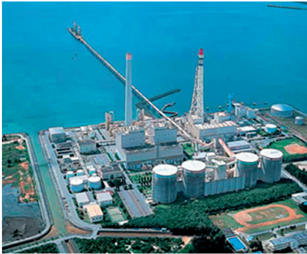
Угольная электростанция Denpatsu
