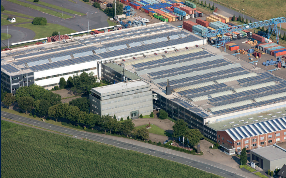
Штабквартира компании AUMUND в г. Райнберг, Германия
