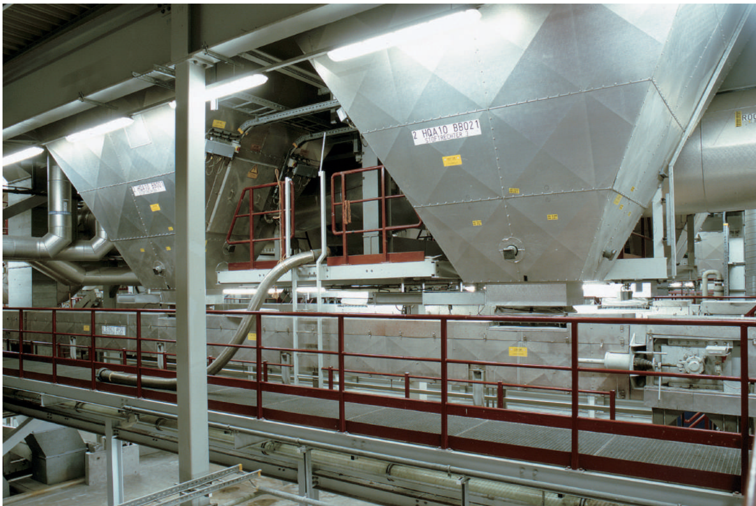
Горячая зола из-под ряда котлов
