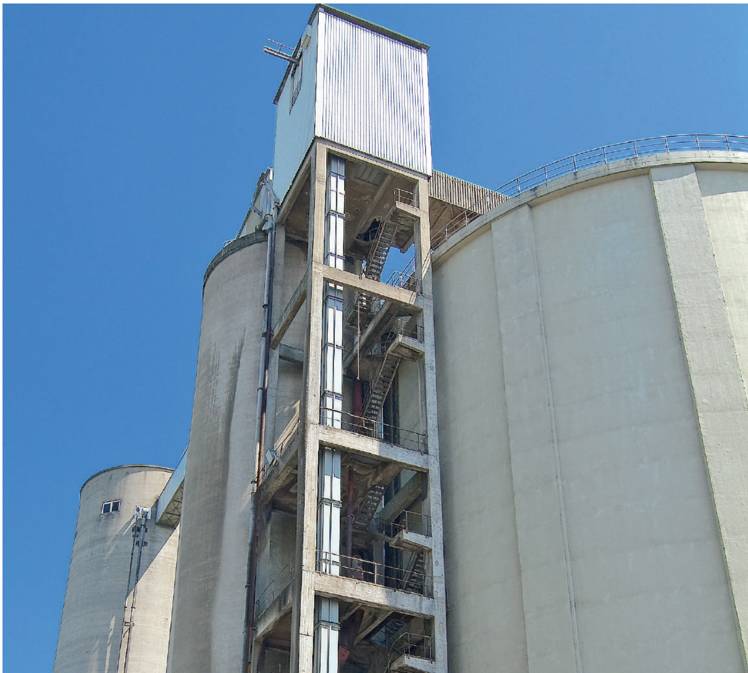
Ковшовый элеватор для загрузки цементных силосов
