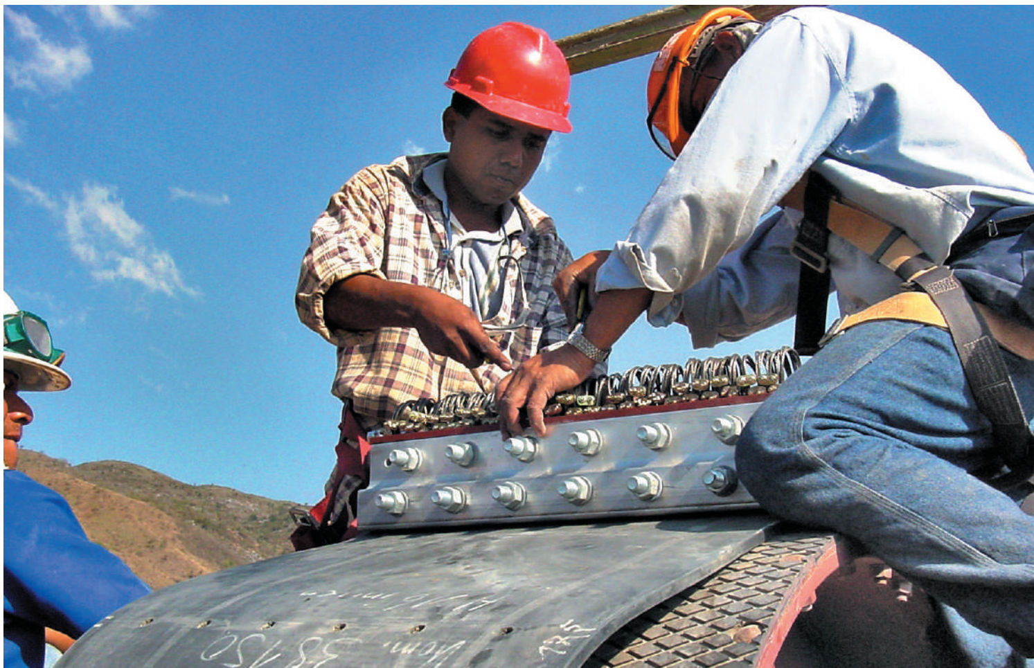
Стыковка концов ленты, армированной стальными тросами
