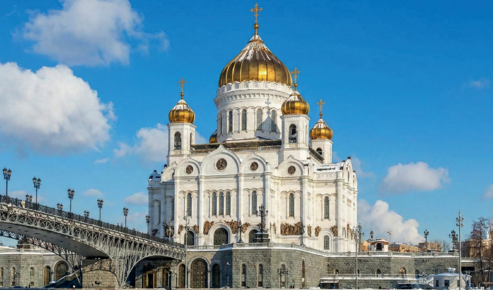
Металлоконструкции купольной части Храма Христа Спасителя, Москва
