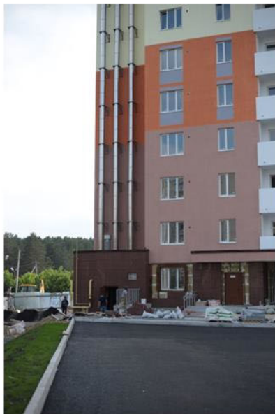
Котельная пристроенная к жилому дому, 2.3 МВт, г Екатеринбург
